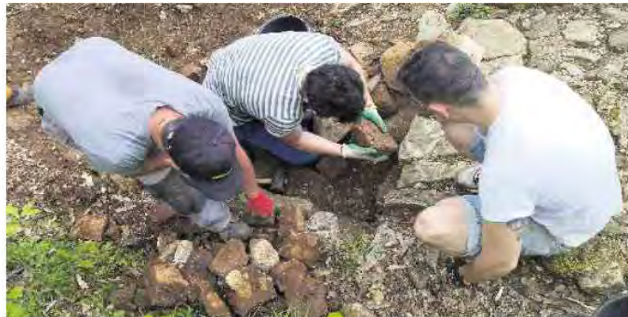
Alles Handarbeit: die angehenden Straßenbauer bei der Sanierung des Weges
